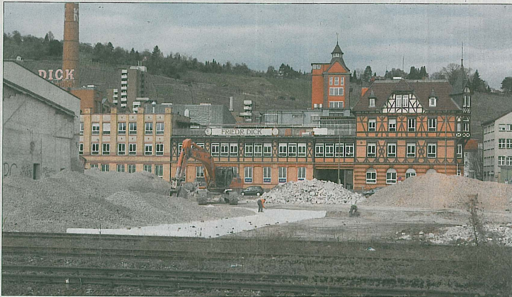
Bagger verrichten auf dem früheren Güterbahnhof zwischen Gleiskörper und Dick ganze Arbeit. Mit dem weit fortgeschrittenen Abbruch der alten Lagerhallen bereiten sie den Bau der Südtangente und der Neuen Weststadt vor. Foto: Bulgrin
